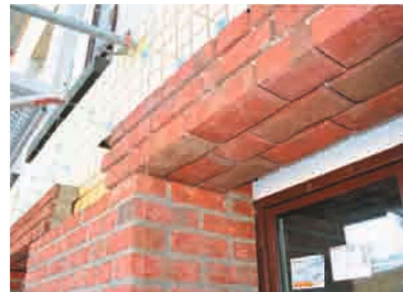
Läufersturz mit direktem Auflager, hier mit größerer Laibungstiefe.
