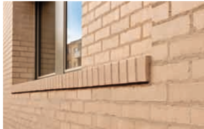
Bündig abgezogene, nicht zusätzlich verdichtete Mörtelfugen.
