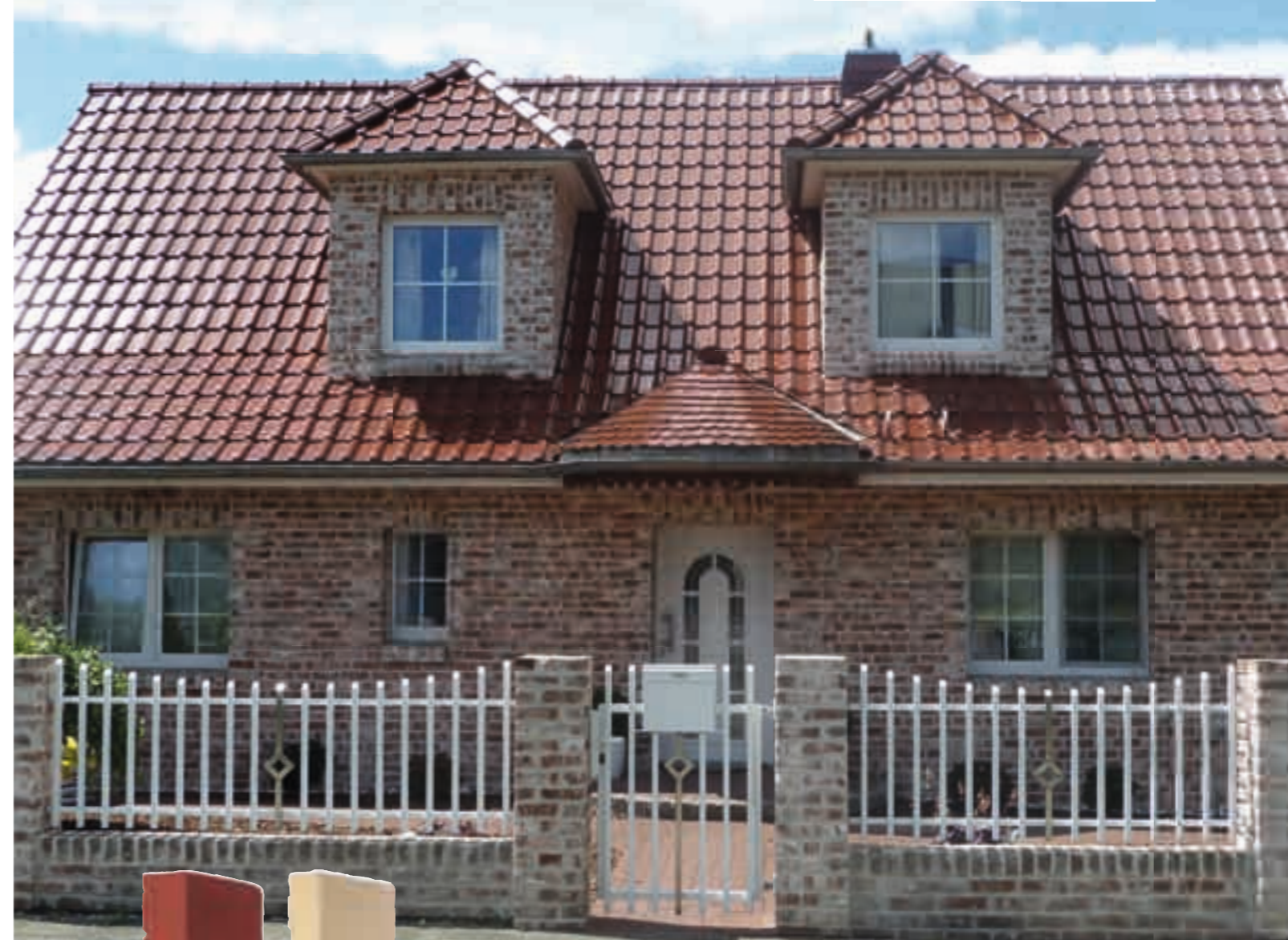
Das zuvor unscheinbare Häuschen (kleines Foto) wurde mit buntweißen Röben GEESTBRAND Handform-Riemchen auf einem WDVS in ein Schmuckstück verwandelt - mit neuem Tondach, neuer Riemchen-Fassade und neuer Gartenmauer.
